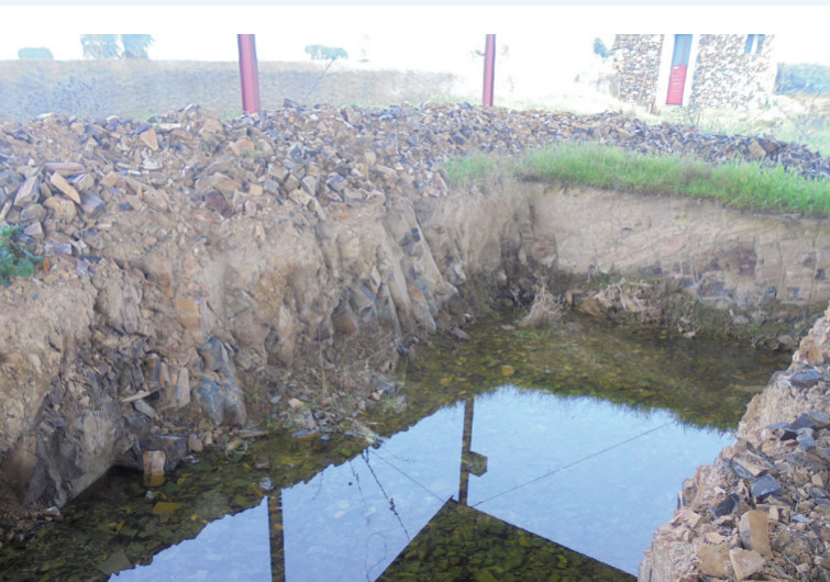
Estanque en construcción en Herdade das Cebolas, Campinho, Portugal. (Enero, 2018). Joana Paulo
